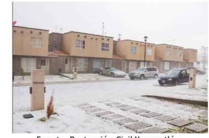
Fuente. Protección Civil Xonacatlán (2022 – 2024)
