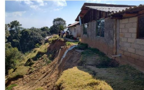
Imagen 5. Posible deslizamiento en las casas que se encuentran en la inestabilidad de las laderas.
