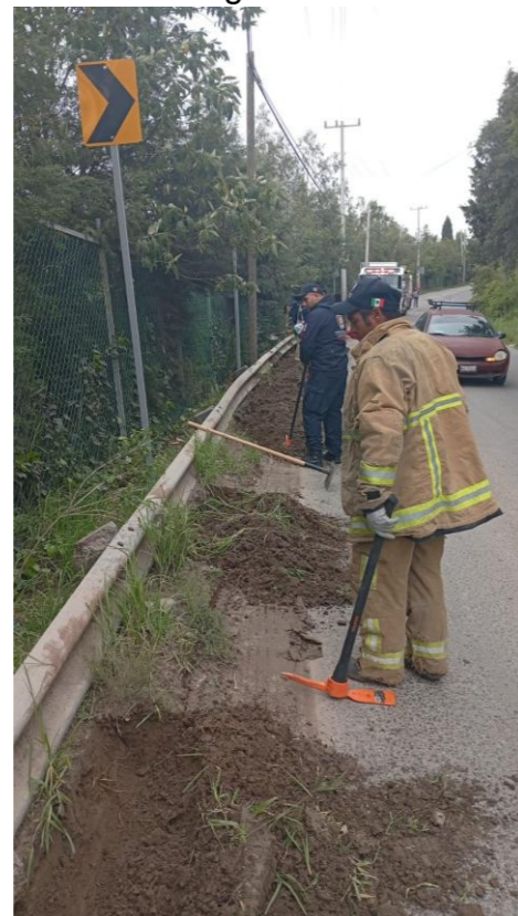
Imagen 19. Remoción de material orgánico en carretera para evitar accidentes.
