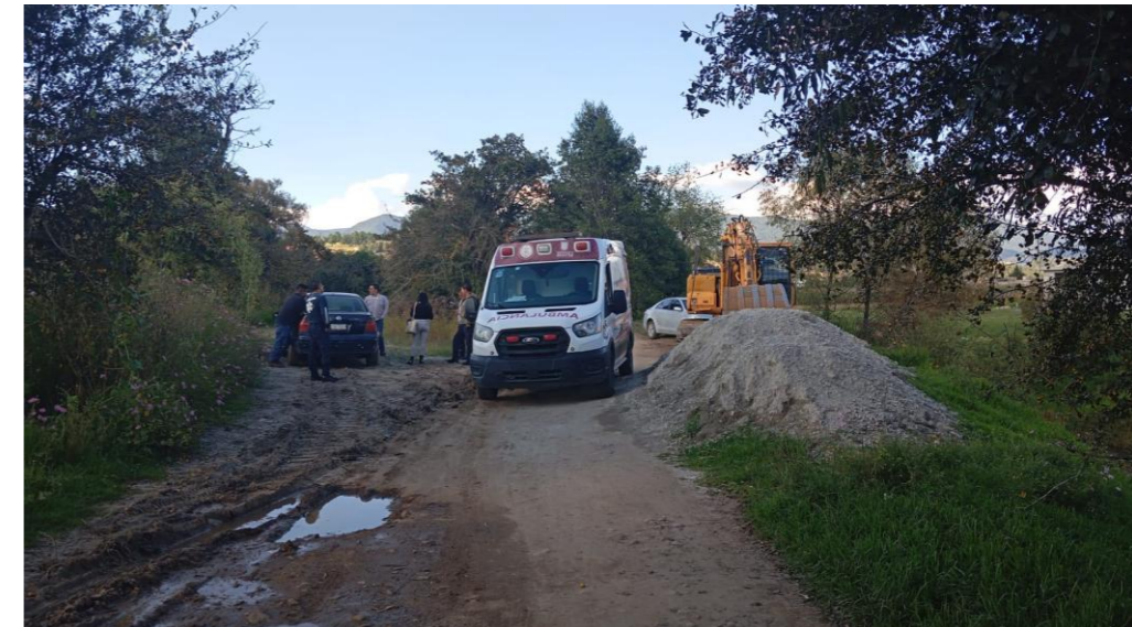
Imagen 8. Revisión de desazolve
