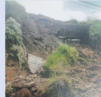
Fuente. Protección Civil Xonacatlán (2022 - 2024)
