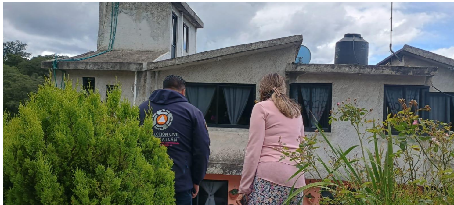
Imagen 15. Recorrido en vivienda, para la identificación de zonas de filtración de agua en la localidad de Santa María Zolotepec, Xonacatlán.
