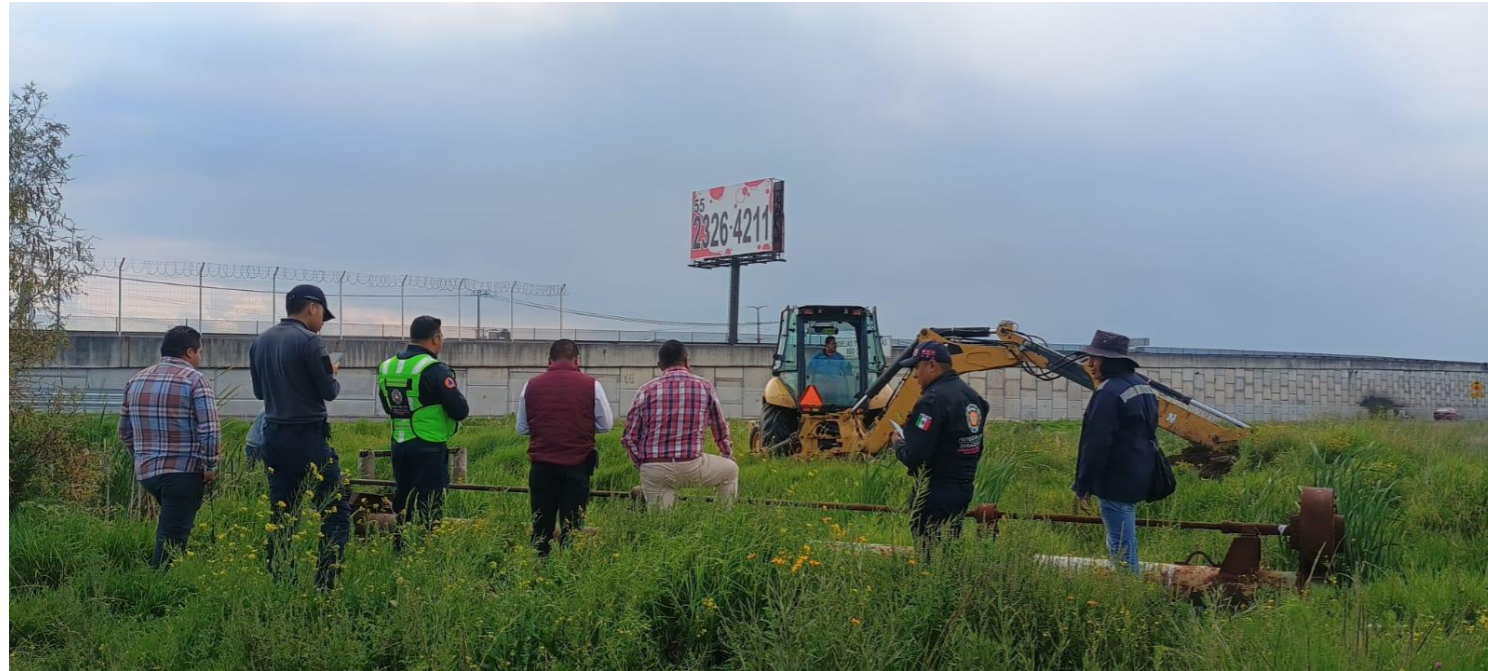
Imagen 14. Recorrido para la identificación de taponamiento en contra zanja del municipio de Xonacatlán, con límites de Oztolotepec.
