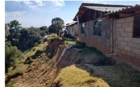
Imagen 5. Posible deslizamiento en las casas que se encuentran en la inestabilidad de las laderas.
