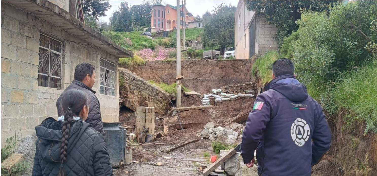
Imagen 10. Recorrido en vivienda por deslizamiento de vialidad en Santa María Zolotepec, Xonacatlán.
