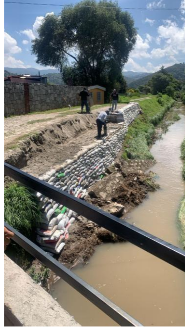
Imagen 20. Trabajo de encostalamiento sobre el Río Mayorazgo.
